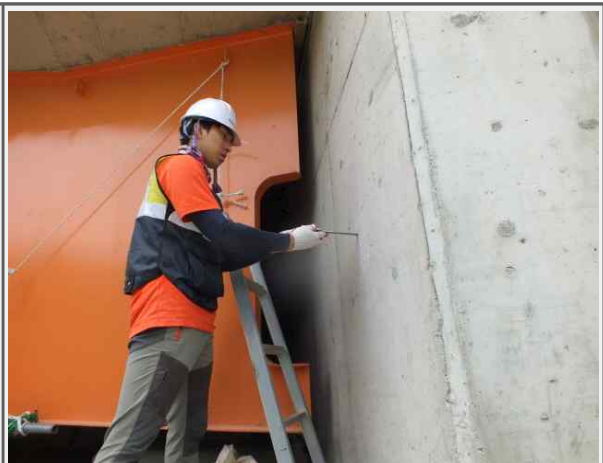
하부구조 탄산화깊이 측정
