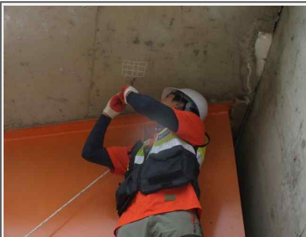
상부구조 탄산화깊이 측정
